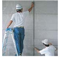
墨出し割付け
