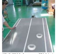
構造用接合テープ貼付け
