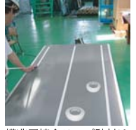
構造用接合テープ貼付け
